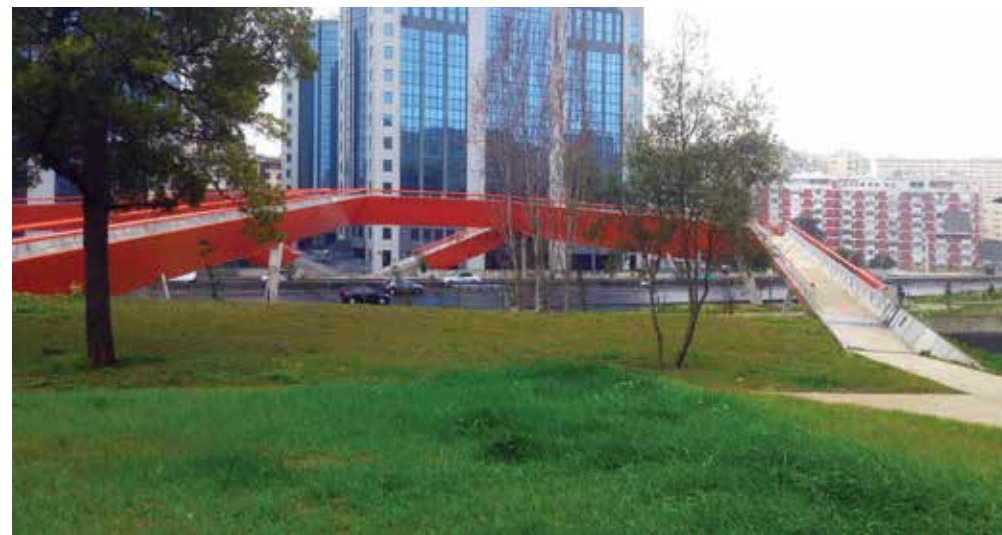
Ponte na 2ª Circular, Lisboa
