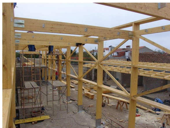
Fig. 2 – Vista Geral da Estrutura
