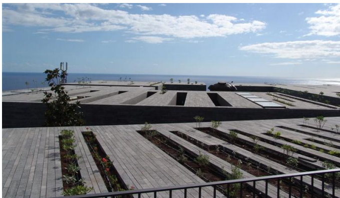
Fig. 2 - Vista da Cobertura
