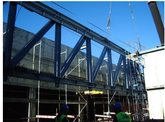
Fig. 5– Montagem de viga treliçada metálica
