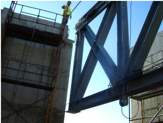
Fig. 3 – Processo de colocação da treliça metálica
