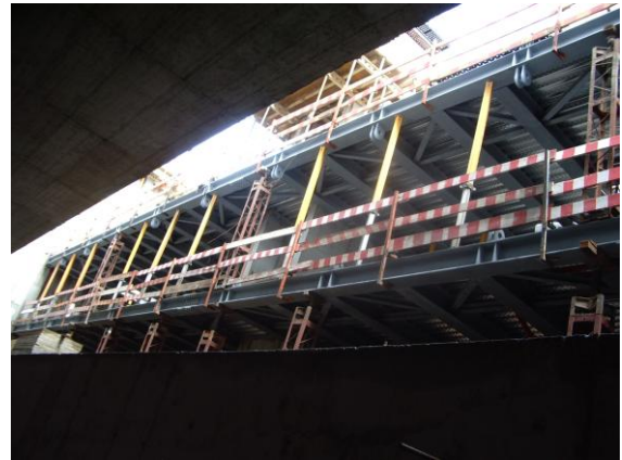
Fig. 4– Vista Geral de Obra
