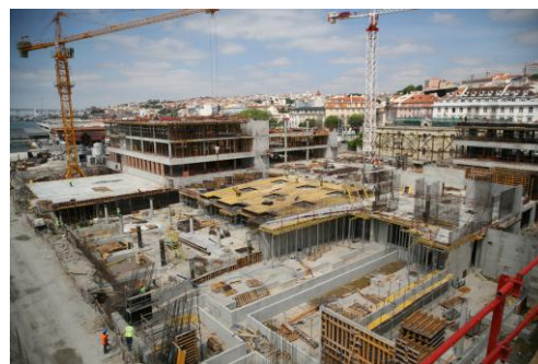
Fig. 1 – Vista geral da construção dos edifícios.
