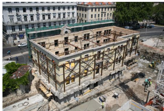
Fig. 4 – Vista do final da escavação
