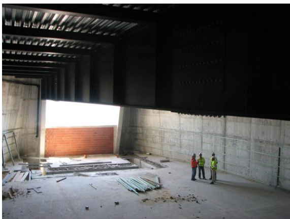
Fig. 3 – Vigas de Alma Cheia da cobertura da Sala de Conferências
