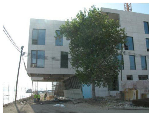
Fig. 2 – Vista da zona do edifício em balanço.
