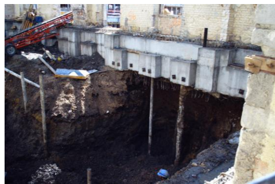
Fig. 5 – Vista da escavação no interior do Palacete
