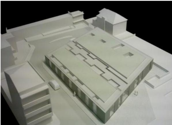
Dada a sua dimensão este edifício é constituído por um único corpo estrutural. A estrutura é constituída por pórticos em betão armado, embora para respeitar a solução arquitectónica a cobertura não seja contínua, encontrando-se subdividida em três lajes distintas separadas por uma clarabóia.
