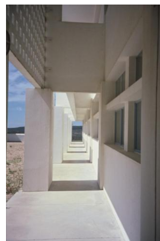
Fig. 1 – Corpo A - Pormenor dos pilares de grandes dimensões da fachada e dos apoios das grelhas”
