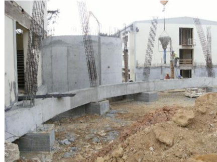
Fig. 7 – Execução do Coberto de ligação
