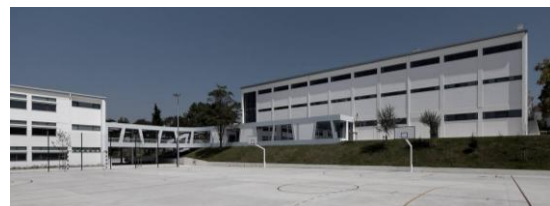
Fig. 9 – Vista geral da escola
