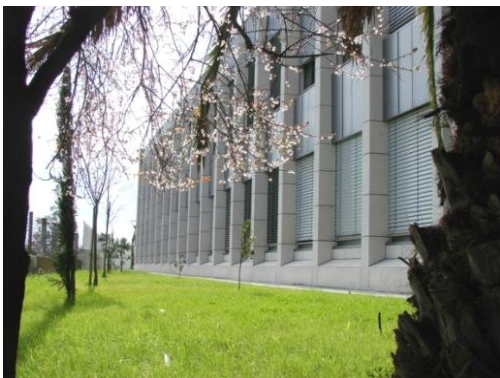
Fig. 7 – Novo Corpo de Aulas
