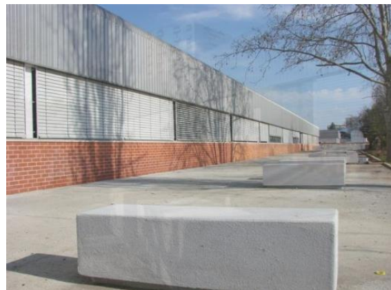
Fig. 3 - Edifício existente após intervenção
