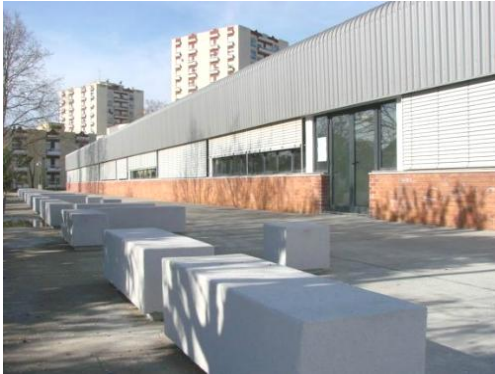
Fig. 4 – Ampliação do Edifício Existente
