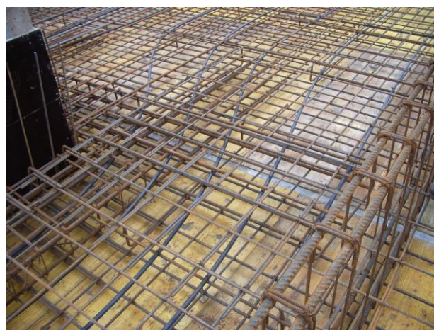
Fig. 3 e 4 – Laje do piso 1 do corpo 1, disposição das armaduras e cabos de pré-esforço.
