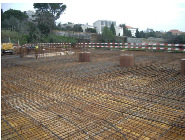
Fig. 3 e 4 – Laje do piso 1 do corpo 1, disposição das armaduras e cabos de pré-esforço.
