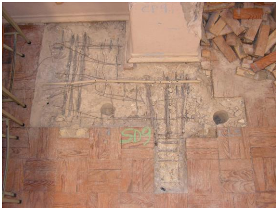
Fig. 3 - Ausência de armadura de punçoamento
