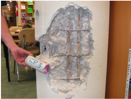
Fig. 2 - Pilares da estrutura antiga
