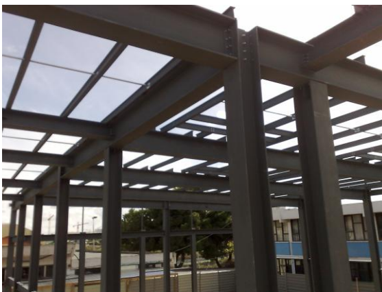
Fig. 2 - Estrutura Metálica do edifício novo
