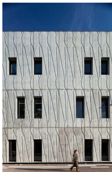
Fig. 3 – Fachada do Novo Edifício
