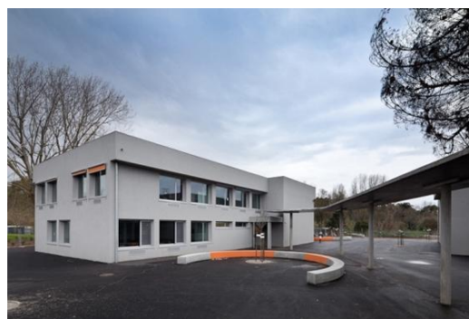
Fig. 1 – Novo Pavilhão e Pala exterior
