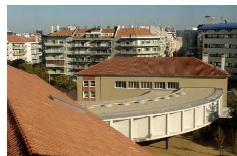
Fig. 2 – Vista exterior da Galeria de ligação
