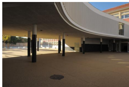
Fig. 3 – Vista inferior da Galeria de ligação
