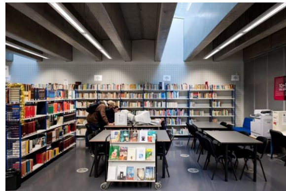
Fig. 1 – Vista da Biblioteca com cobertura formada por vigas pré-fabricadas em betão armado pré-esforçado.
