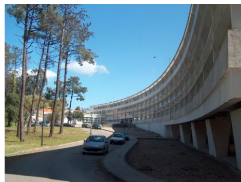
Fig. 1 – Vista do piso vazado do edifício "curvo"
