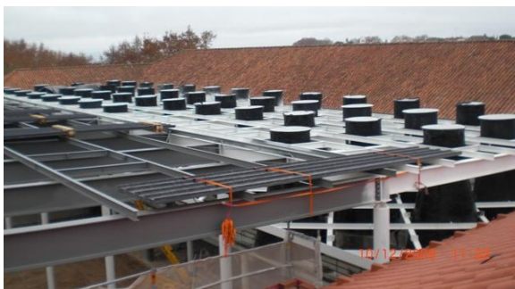
Fig. 2 – Corpo do ginásio em fase de construção.
