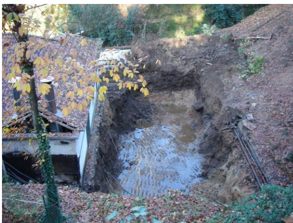
Fig. 1 – Escavação na zona 3.
