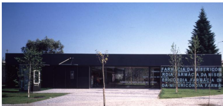
Fig. 1 – Fachada do edifício da Farmácia.
