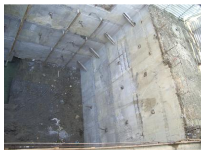
Fig. 2 - Escavação e Contenção Periférica
