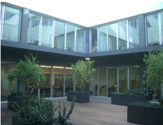
Fig. 4 - Pisos 0 e -1 vistos do pátio
