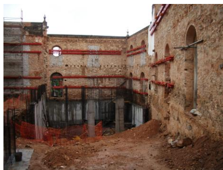
Fig. 3 – Escavação das Antigas Cavalariças com a execução dos muros faseada
