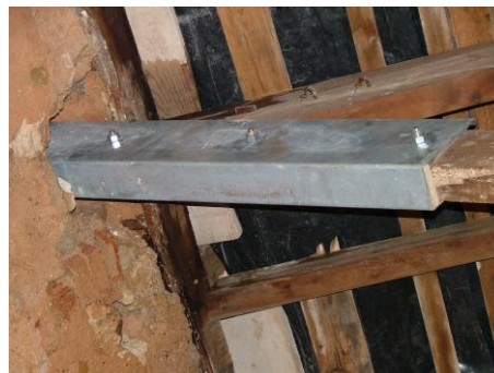
Fig. 2 –Reforço das asnas da cobertura do palacete
