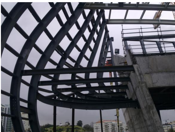
Fig. 5 – Montagem da estrutura metálica no Coro Alto e no Altar
