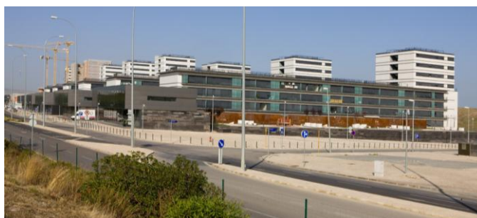
Fig. 1 – Panorâmica do empreendimento.
