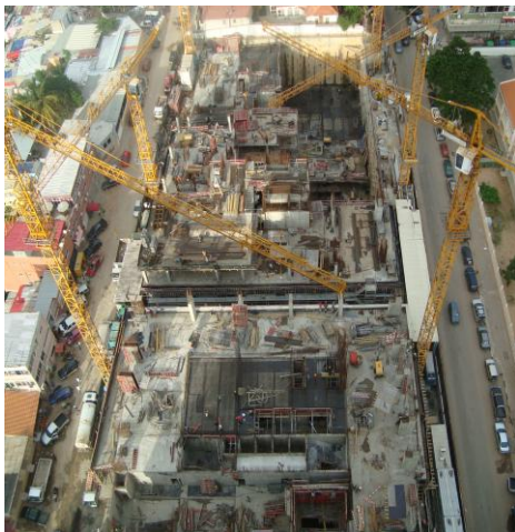
Fig. 1 – Vista Geral da Obra
