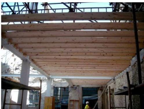
Fig. 6 e 7 - Estrutura dos pavimentos em fase de obra. Detalhe dos pavimentos em estrutura mista
