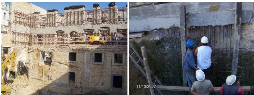
Fig. 9 - Vista geral da escavação. Arranque do muro de contenção. Viga de coroamento. Montagem do painel primário
