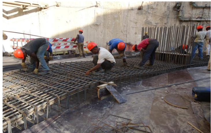
Fig. 4 – Fotografia: Colocação em Obra da Armadura de uma Nervura
