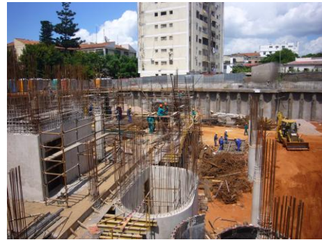
Fig. 3 – Decorrer da Obra - Pisos Enterrados
