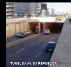
TUNEL DA AV. DA REPÚBLICA
