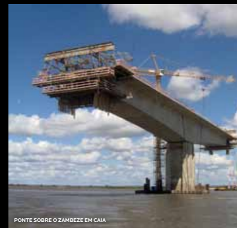
PONTE SOBRE O ZAMBEZE EM CAIA
