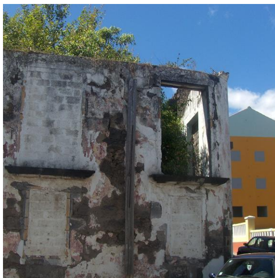
Fig. 2 Vista do Edifício antes da intervenção e sua envolvente
