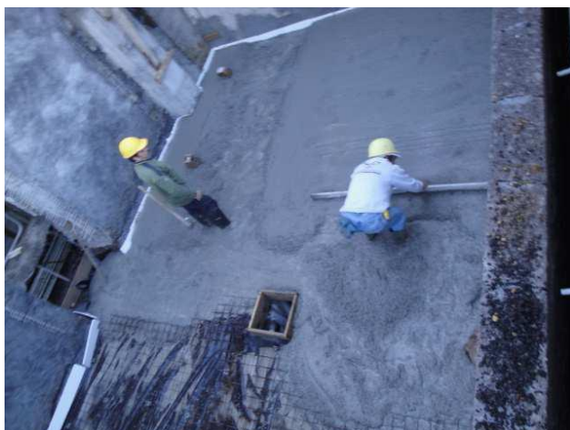
Fig. 3 Betonagem da Laje Térrea
