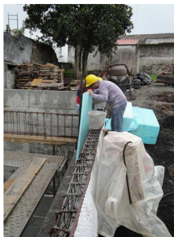
Fig. 4 Impermeabilização das paredes exteriores enterradas
