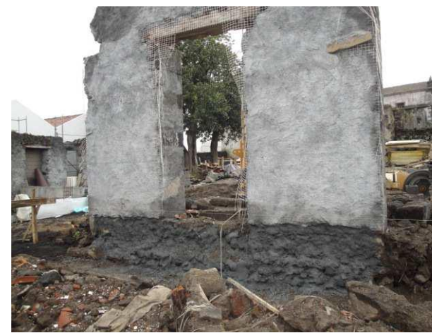
Fig. 5 Consolidação de troço de parede a manter
