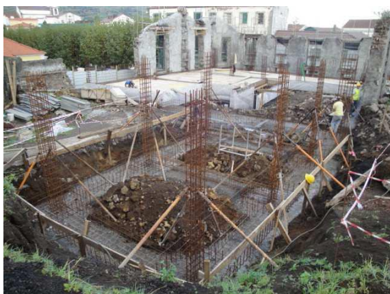
Fig. 6 Execução de Fundações
