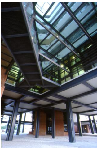
Fig. 1 – Vista do piso da entrada onde se podem observar os pilares metálicos, o passadiço e os lanternins”
