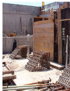
Fig. 4 - Sistema para absorção de esforços de corte e de tracção nas fundações
