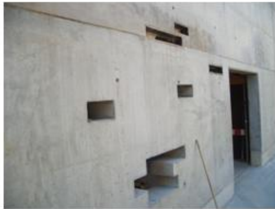
Fig. 7 – Pormenores dos negativos na fachada em betão à vista
