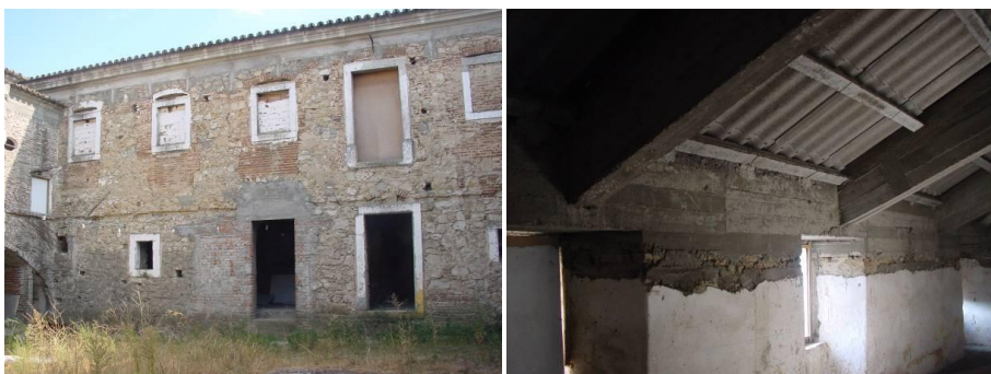
Fig. 1 e 2 – Paredes resistentes. Cobertura em vigas de betão e sub-telha de fibrocimento
