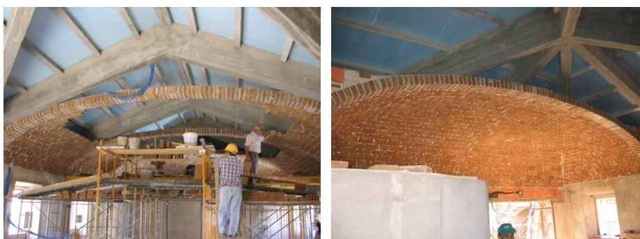
Fig. 4 - Construção das abóbadas de arco de cesto, escondendo a cobertura préexistente
